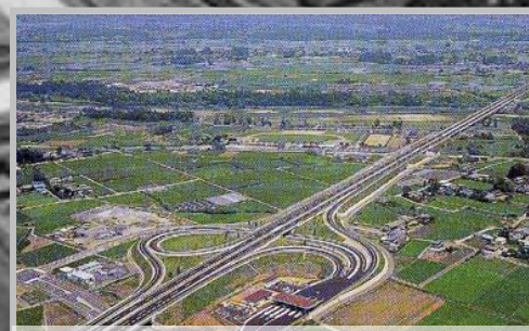
北関東自動車道
